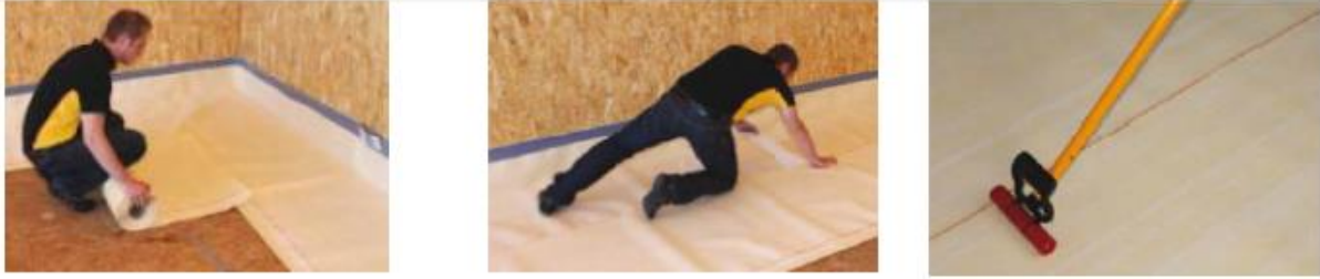
Şekil 2: SikaProof membran temel uygulama detayları
