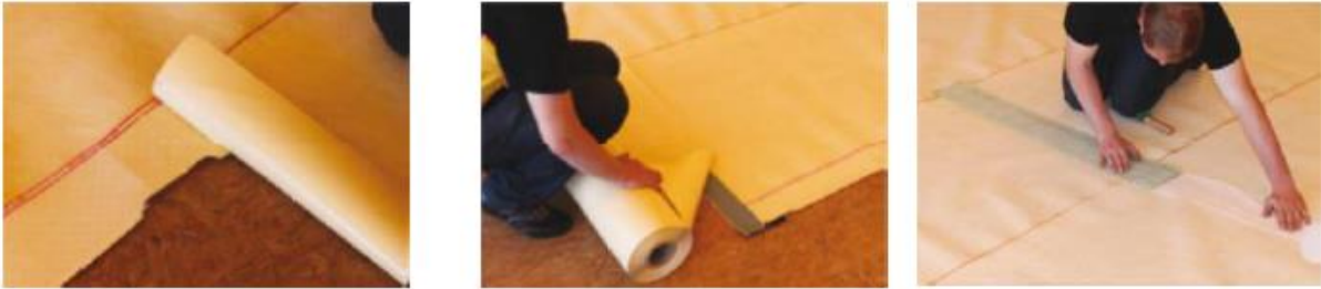
Şekil 3: SikaProof A, membran bitiş detayları
