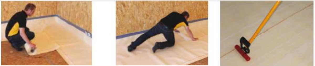
Şekil 2: SikaProof membran temel uygulama detayları
