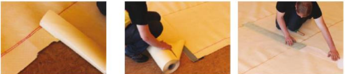
Şekil 3: SikaProof A, membran bitiş detayları
