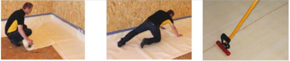
Şekil 2: SikaProof membran temel uygulama detayları
