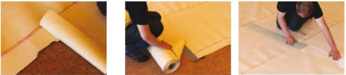
Şekil 3: SikaProof A, membran bitiş detayları
