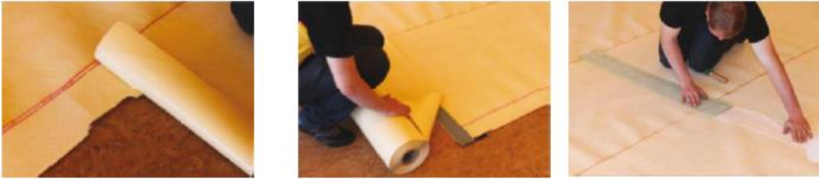
Şekil 3: SikaProof A, membran bitiş detayları
