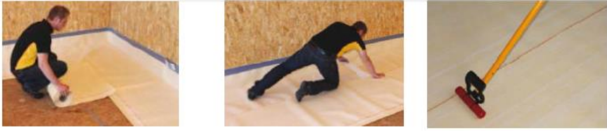
Şekil 2: SikaProof membran temel uygulama detayları
