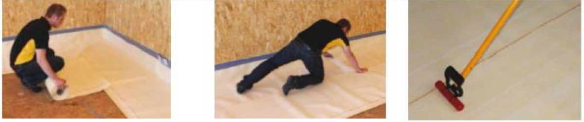
Şekil 2: SikaProof membran temel uygulama detayları
