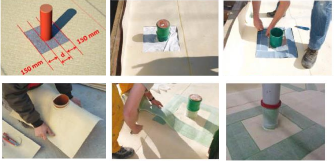
Şekil 4: SikaProof A membran, boru geçiş detayları
